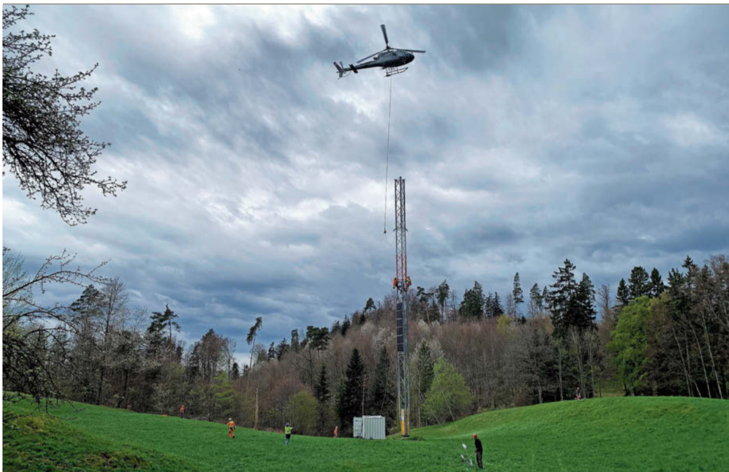
In zweieinhalb Stunden ist der Windmessmast auf dem Batzberg abgebaut worden.
